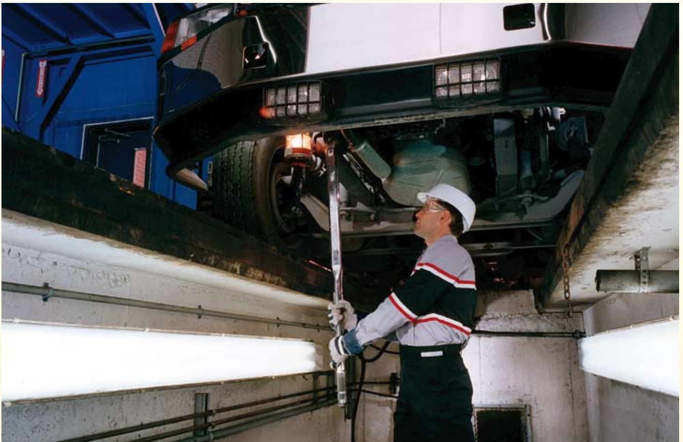
Figure 1. Une fosse de réparation.
